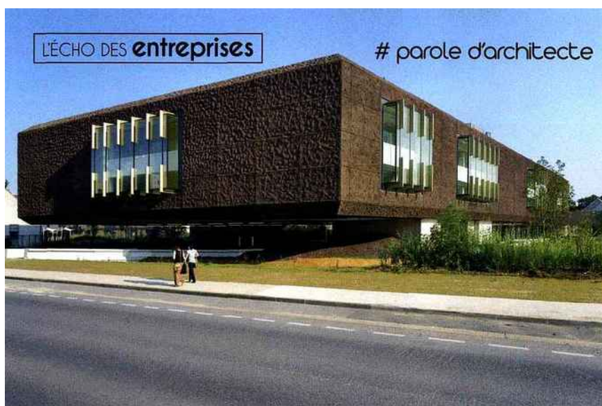
La bibliothèque universitaire de Marne-la-Vallée : sur le bâtiment principal, des boîtes vitrées (H. 8 m) serties dans le parement en béton projeté. © Olivier Amsellem.
